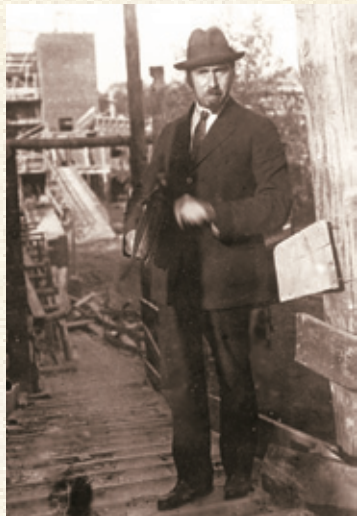
И.И. Сидорин на строительстве ЦАГИ (20-е годы)
