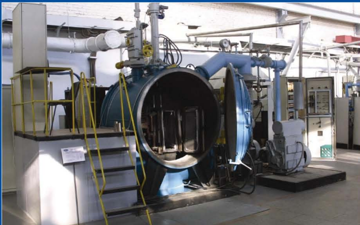
Плавильно-заливочная установка УВНК-14 для отливки крупногабаритных монокристаллических лопаток
